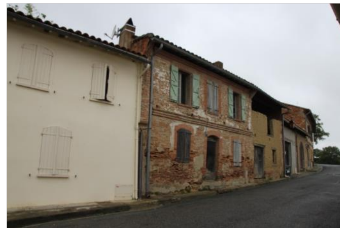
Figure 78 : Bâti ancien et rénové juxtaposé Source : L'Artifex
