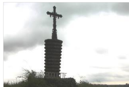
Figure 80 : Croix – « Château de la Roquette » Source : L'Artifex
