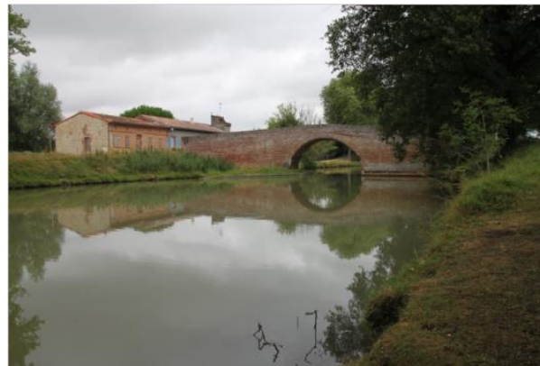
Figure 74 : Pont d'en Serny Source : L'Artifex
